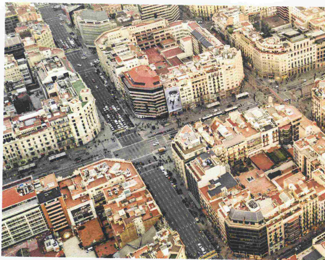
La spettrale Masdar, negli Emirati Arabi, e, sopra, i caratteristici isolati smussati di Barcellona, che favoriscono l'incontro.
